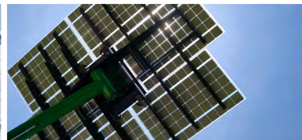
Panamá Paneles solares
