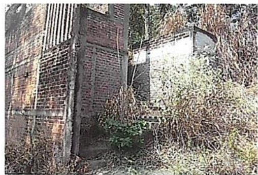
VISTA DE LAS CONSTRUCCIONES EXISTENTES
