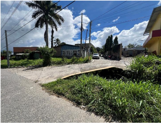
VISTA ENTRADA SOBRE AUTOPISTA COMALAPA
